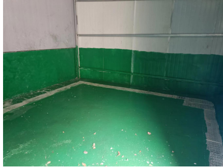
危废库防渗地面
