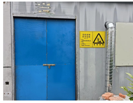
危废库门口标志牌
