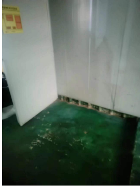
危废库防渗地面
