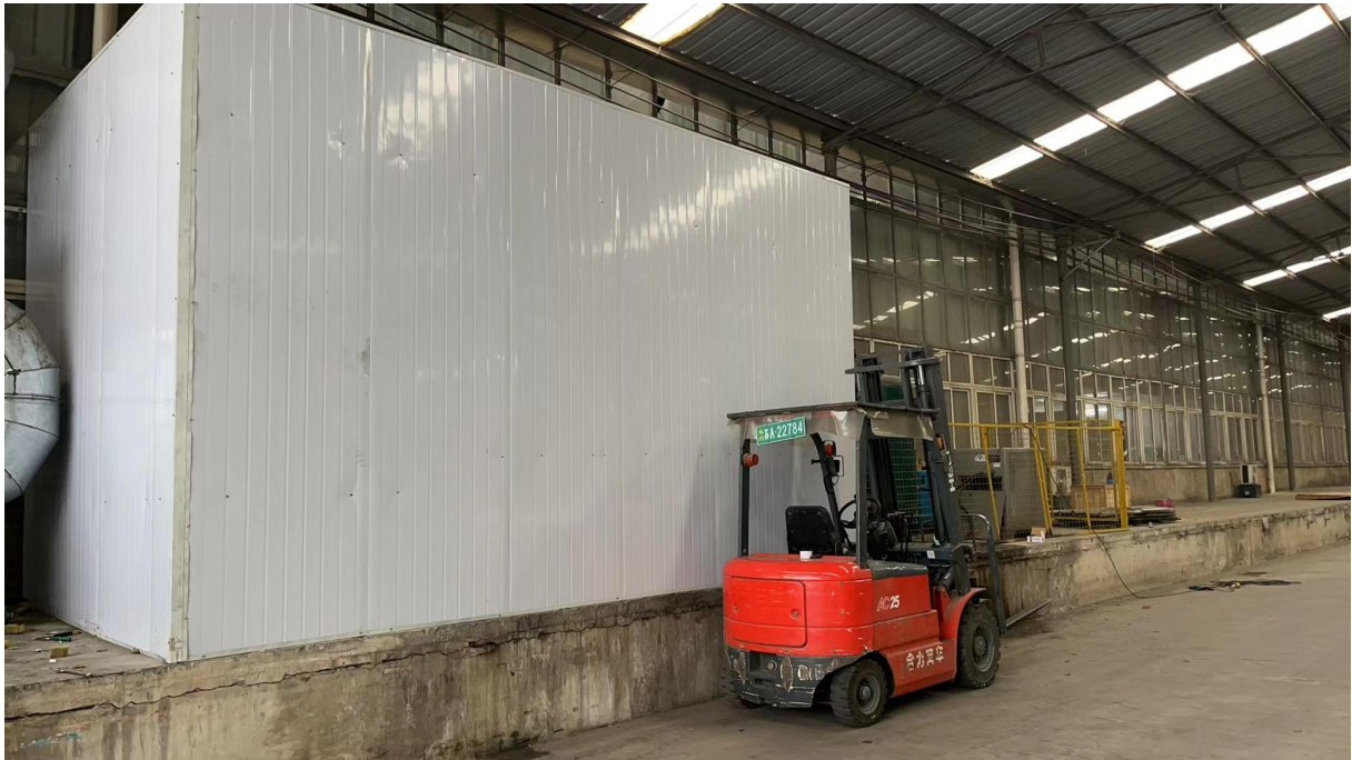
图 7-1 冷却塔加装隔声板照片
