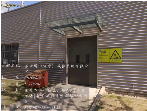
危废库大门及标识牌
